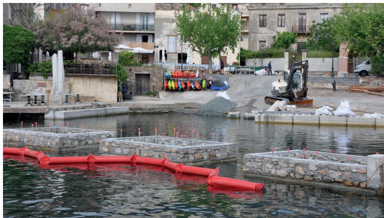
D'importants travaux de remise en état et de modernisation ont été entrepris l'an passé.
